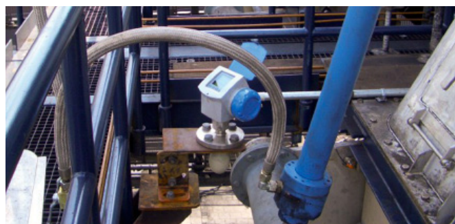
Радарный уровнемер OPTIWAVE 6300C на автоматической загрузке группирующей машины коксовой печи
