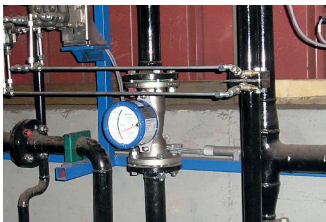
Ротаметры H250 M40 Ду50 на подаче защитного газа азота в промышленные печи
