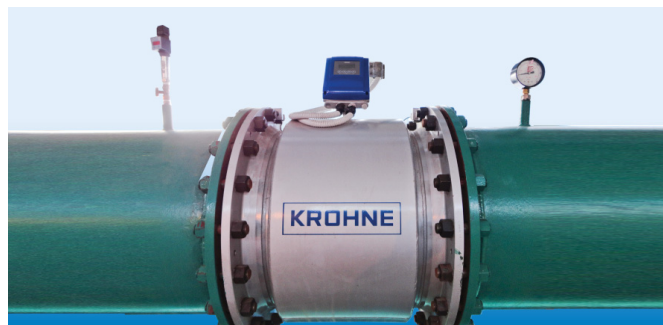
Электромагнитный расходомер OPTIFLUX 2100 на учете воды подаваемой на стан 5000 на Выксунском металлургическом заводе
